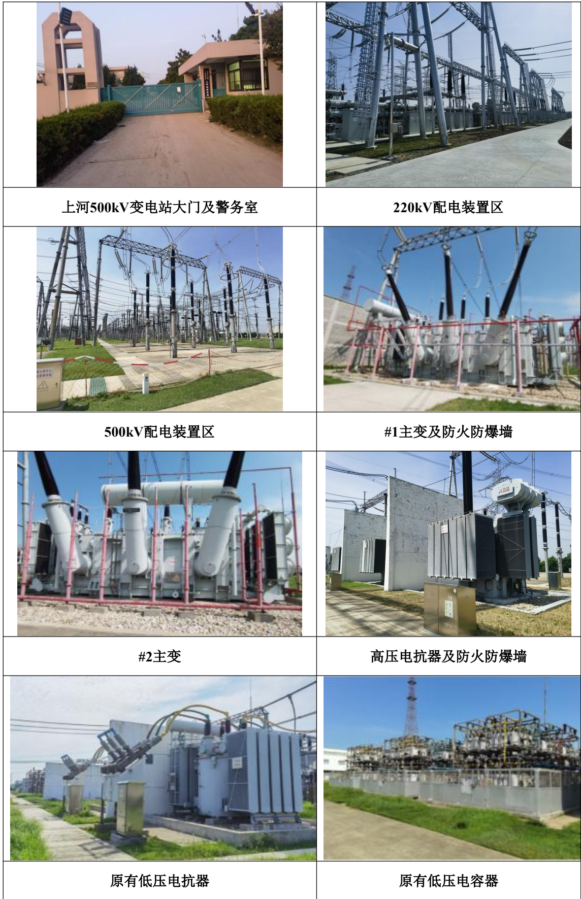
图3-1 上河500kV变电站原有工程
