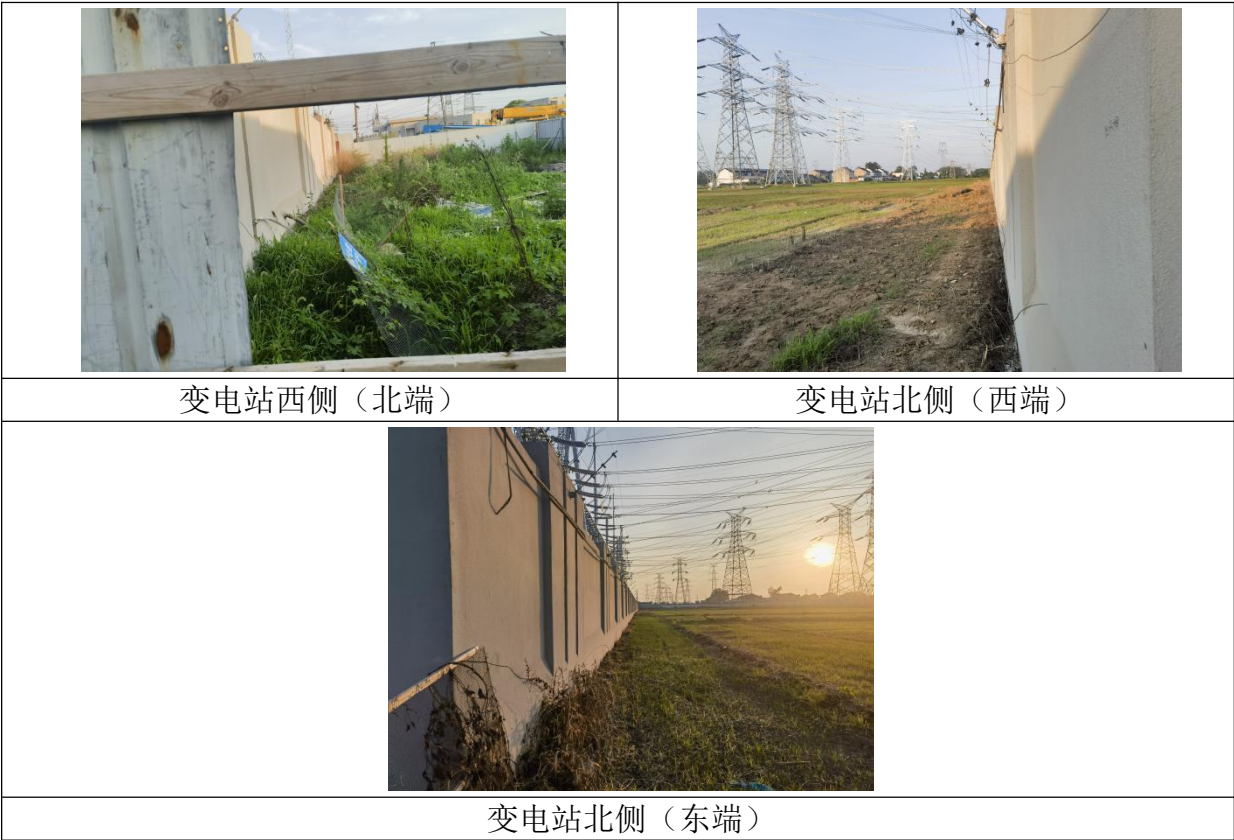
图 2-2 上河 500kV 变电站四周照片
