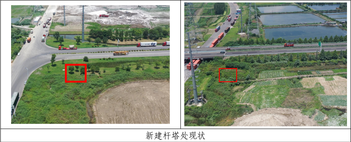
图 1.1-2 线路工程沿线现状照片
