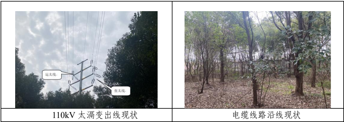
图 1.1-4 本工程线路沿线现状照片
