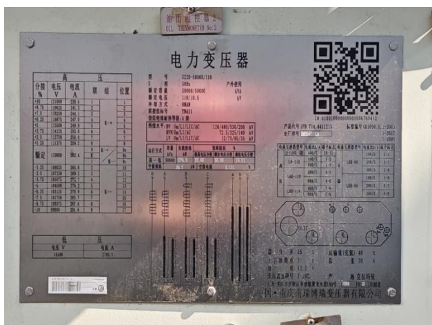
高桥 110kV 变电站#1 主变铭牌
