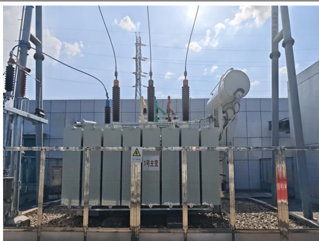
高桥 110kV 变电站#1 主变压器（本期）
