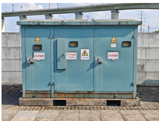
高桥 110kV 变电站接地变
