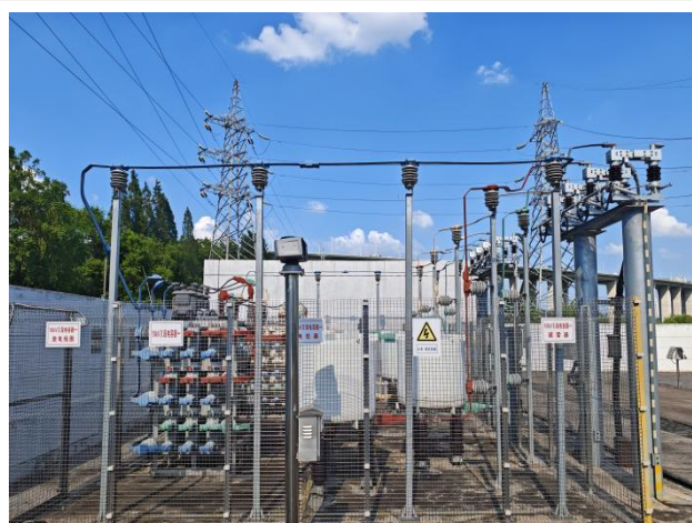
高桥 110kV 变电站电容器组
