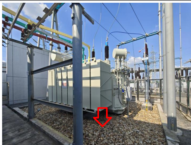
高桥 110kV 变电站#1 主变压器事故油坑
