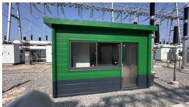
梁庄 220kV 变电站雨淋阀舱
