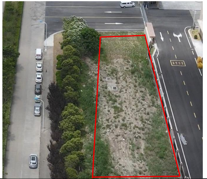
电缆施工区撒播草籽 (2025.7)
