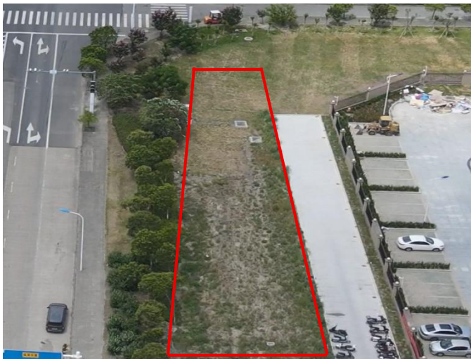
电缆施工区撒播草籽 (2025.7)
