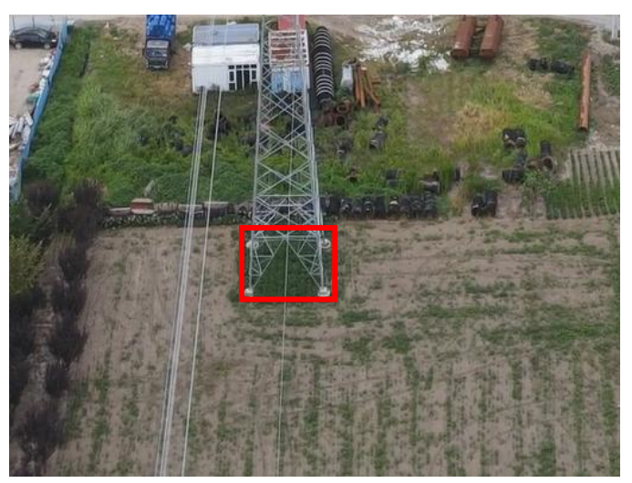
塔基及塔基施工区 T16 复耕 (2025.7)
