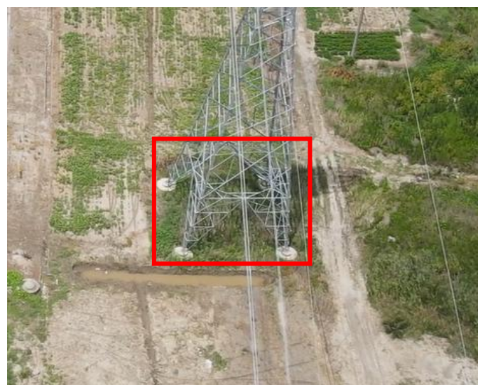
塔基及塔基施工区 T10 复耕及撒播草籽 (2025.7)
