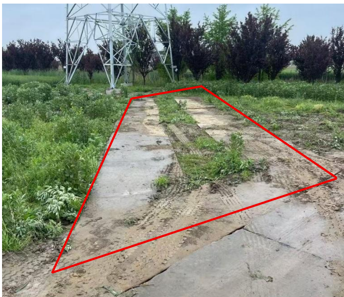
临时道路区铺设钢板 (2024.4)
