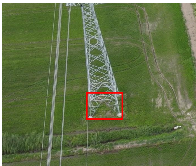
塔基及塔基施工区 T17 复耕 (2025.7)
