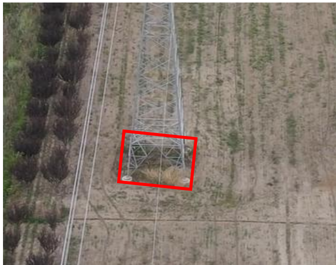
塔基及塔基施工区 T15 复耕 (2025.7)
