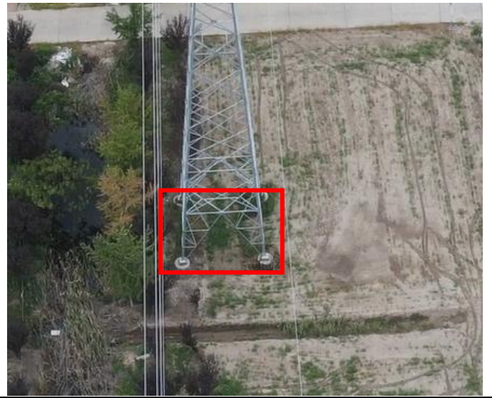
塔基及塔基施工区 T14 复耕及撒播草籽 (2025.7)
