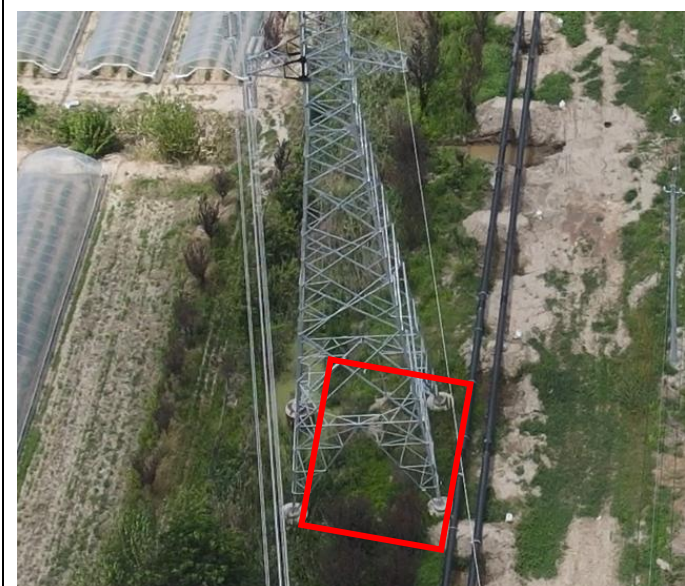
塔基及塔基施工区 T11 复耕及撒播草籽 (2025.7)
