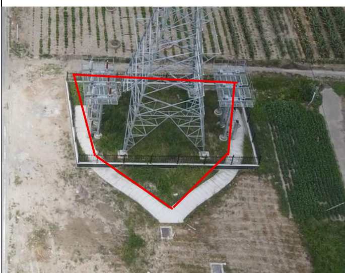
塔基及塔基施工区 T9 复耕及撒播草籽 (2025.7)
