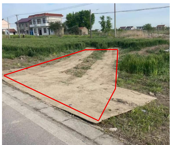
临时道路区铺设钢板 (2024.4)
