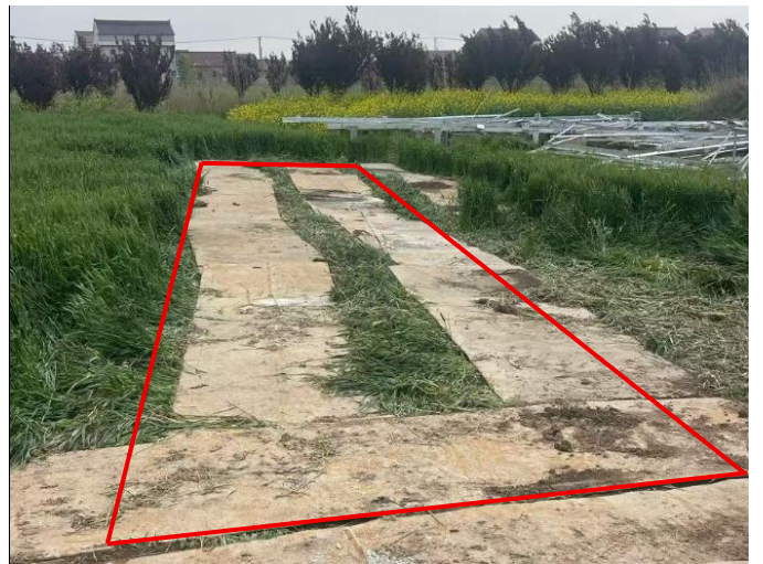
临时道路区铺设钢板 (2024.4)
