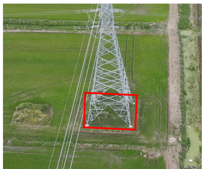
塔基及塔基施工区 T18 复耕 (2025.7)
