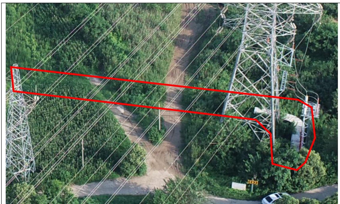
电缆施工，复耕、撒播草籽（2024.06）
