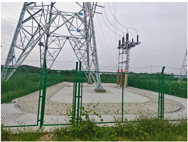
塔基地面硬化、围挡 （110kV 河区 77E 线中核田湾支线 001 号塔）
