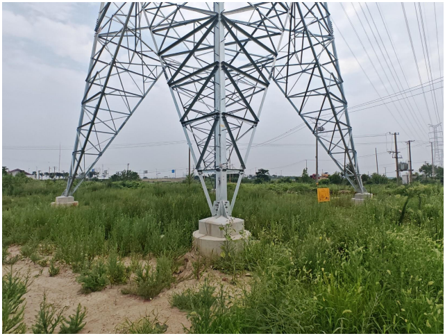
塔基周围生态恢复 （110kV 河区 77E 线中核田湾支线 009 号塔）
