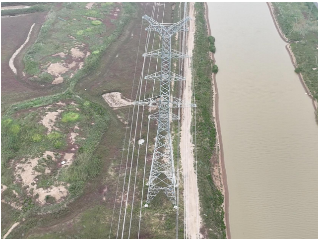
塔基周围生态恢复 （110kV 河区 77E 线中核田湾支线 028 号塔）
