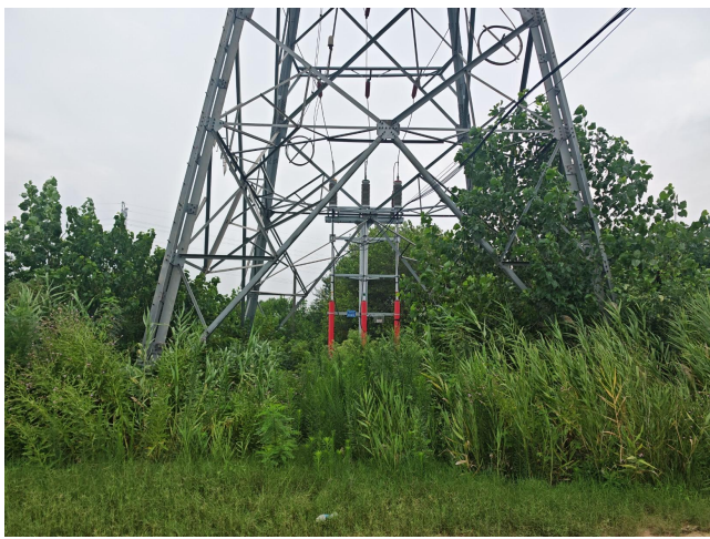
塔基周围生态恢复 （110kV 河区 77E 线中核田湾支线 000 号塔）
