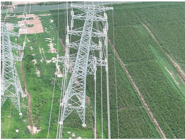
塔基周围生态恢复 （110kV 河区 77E 线中核田湾支线 003 号塔）
