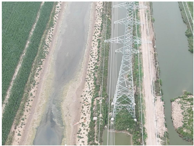
塔基周围生态恢复 （110kV 河区 77E 线中核田湾支线 014 号塔）
