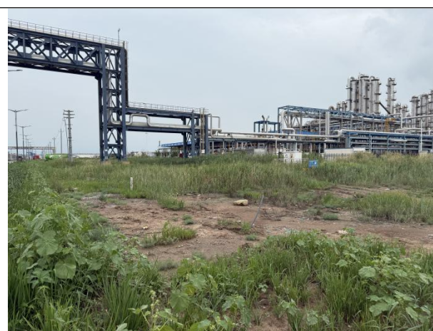
已拆除施工移动板房区域
