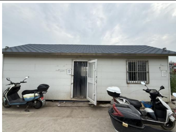
江苏思派新能源科技有限公司员工休息室
