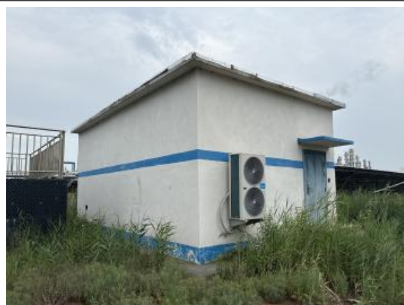
光伏区运维人员值班室
