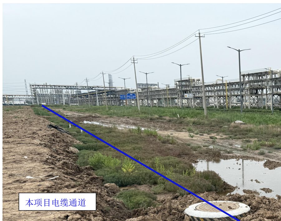
本项目 110kV 双回电缆通道
