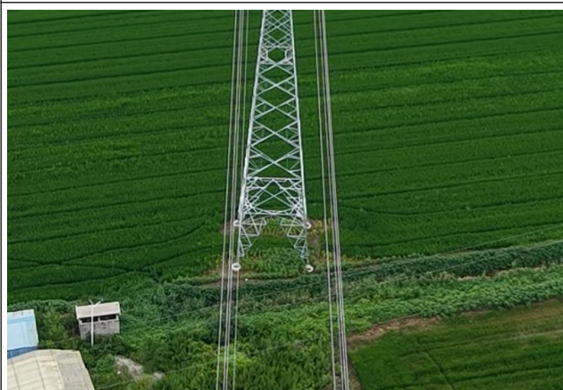
位于生态空间管控区域内塔基周围恢复 (110kV 瀛刘 7BA 线#049/110kV 邓瀛 86C 线 #120)
