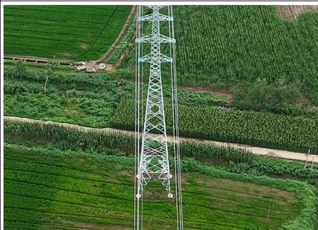
位于生态空间管控区域内塔基周围恢复 (110kV 瀛刘 7BA 线#036/110kV 邓瀛 86C 线#133)
