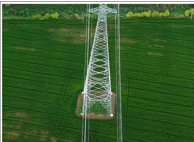
位于生态空间管控区域内塔基周围恢复 (110kV 瀛刘 7BA 线#040/110kV 邓瀛 86C 线#129)
