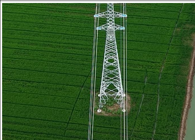
位于生态空间管控区域内塔基周围恢复 (110kV 瀛刘 7BA 线#038/110kV 邓瀛 86C 线#131)
