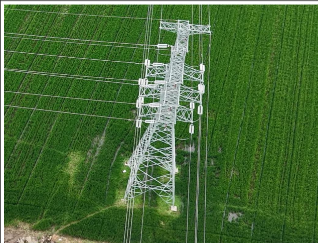
位于生态空间管控区域内塔基周围恢复 (110kV 蔷邓 741 线#053/110kV 瀛刘 7BA 线 #051/110kV 邓瀛 86C 线#118)
