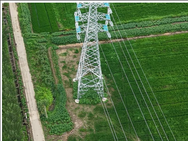
位于生态空间管控区域内塔基周围恢复 (110kV 瀛刘 7BA 线#050/110kV 邓瀛 86C 线#119)
