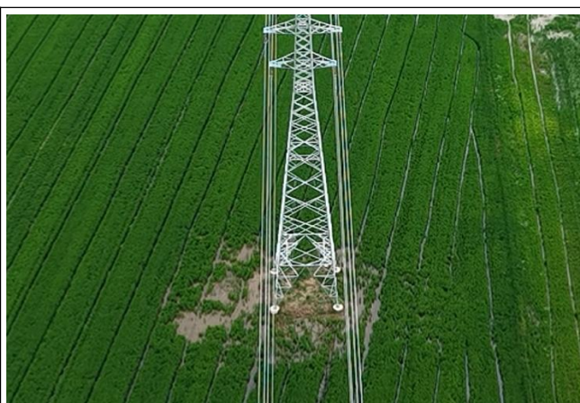
位于生态空间管控区域内塔基周围恢复 (110kV 瀛刘 7BA 线#034/110kV 邓瀛 86C 线#135)
