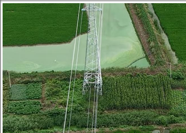
位于生态空间管控区域内塔基周围恢复 (110kV 瀛刘 7BA 线#031/110kV 邓瀛 86C 线 #138)
