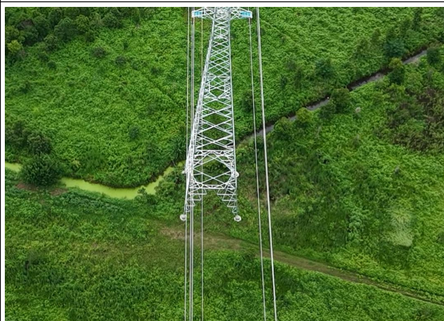
位于生态空间管控区域内塔基周围恢复 (110kV 瀛刘 7BA 线#044/110kV 邓瀛 86C 线#125)
