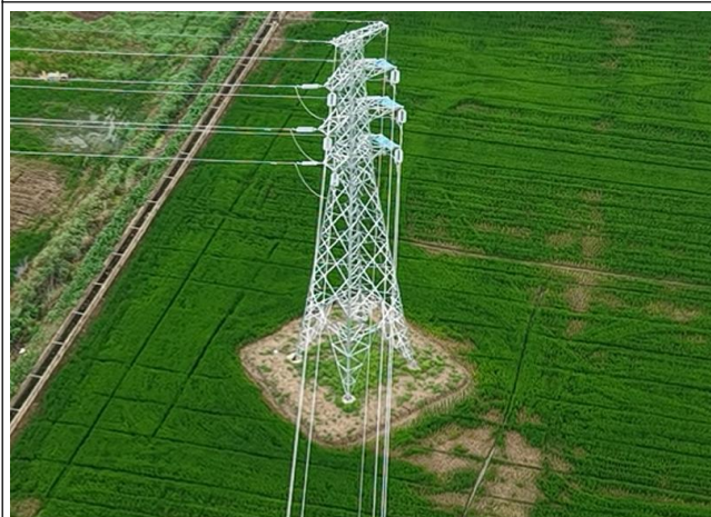
位于生态空间管控区域内塔基周围恢复 (110kV 瀛刘 7BA 线#037/110kV 邓瀛 86C 线 #132)
