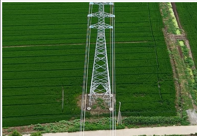
位于生态空间管控区域内塔基周围恢复 (110kV 瀛刘 7BA 线#032/110kV 邓瀛 86C 线#137)
