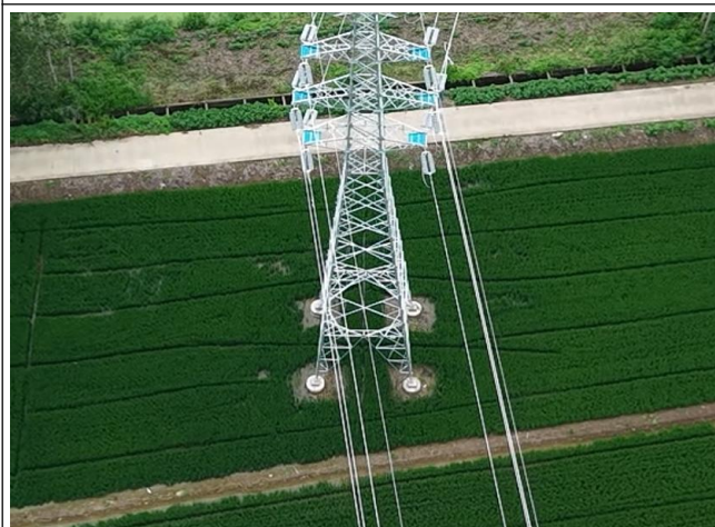
位于生态空间管控区域内塔基周围恢复 (110kV 瀛刘 7BA 线#043/110kV 邓瀛 86C 线 #126)
