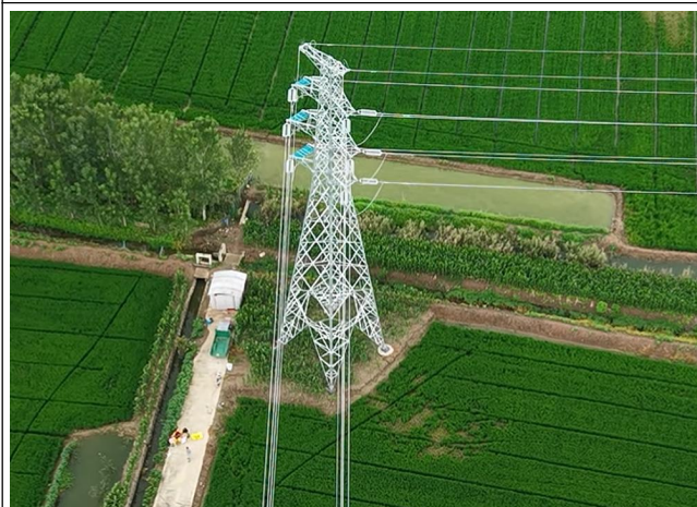
位于生态空间管控区域内塔基周围恢复 (110kV 瀛刘 7BA 线#039/110kV 邓瀛 86C 线 #130)
