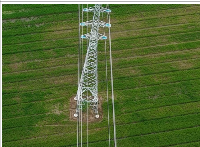
位于生态空间管控区域内塔基周围恢复 (110kV 瀛刘 7BA 线#042/110kV 邓瀛 86C 线#127)
