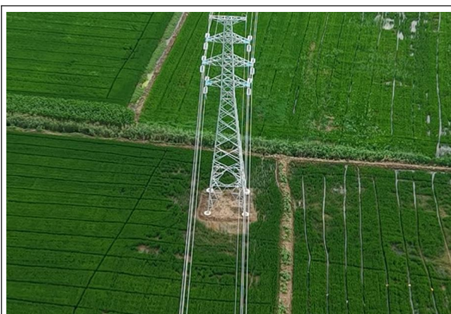
位于生态空间管控区域内塔基周围恢复 (110kV 瀛刘 7BA 线#035/110kV 邓瀛 86C 线 #134)
