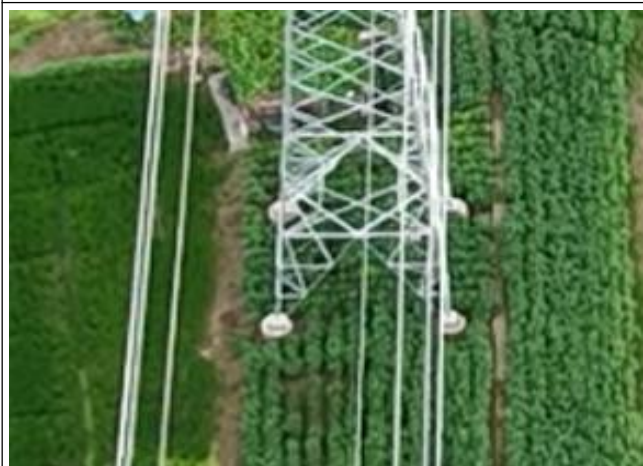
位于生态空间管控区域内塔基周围恢复 (110kV 瀛刘 7BA 线#045/110kV 邓瀛 86C 线 #124)
