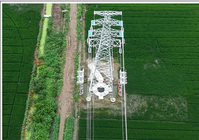
位于生态空间管控区域内塔基周围恢复 (110kV 瀛刘 7BA 线#046/110kV 邓瀛 86C 线#123)
