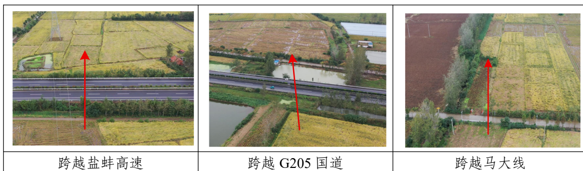
图 1.1-5 本工程架空线路跨越情况照片
