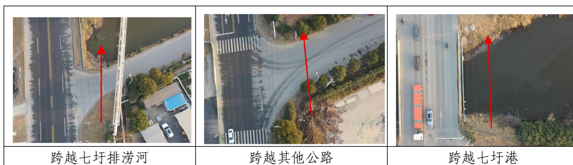
图 1.1-5 本工程架空线路跨越情况照片
